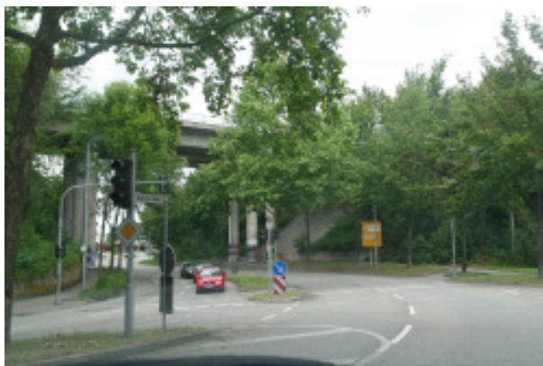
Abbildung 3.8: Bahnbrücke im Zuge der Westtangente
